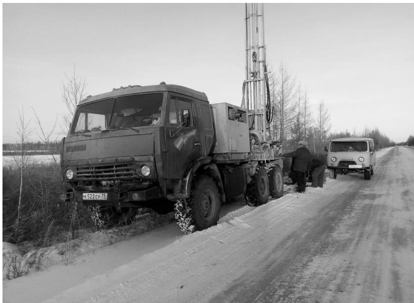
**Рис. 3. Бурение скважин с отбором проб для определения физико-механических свойств грунта насыпи и основания дороги**
