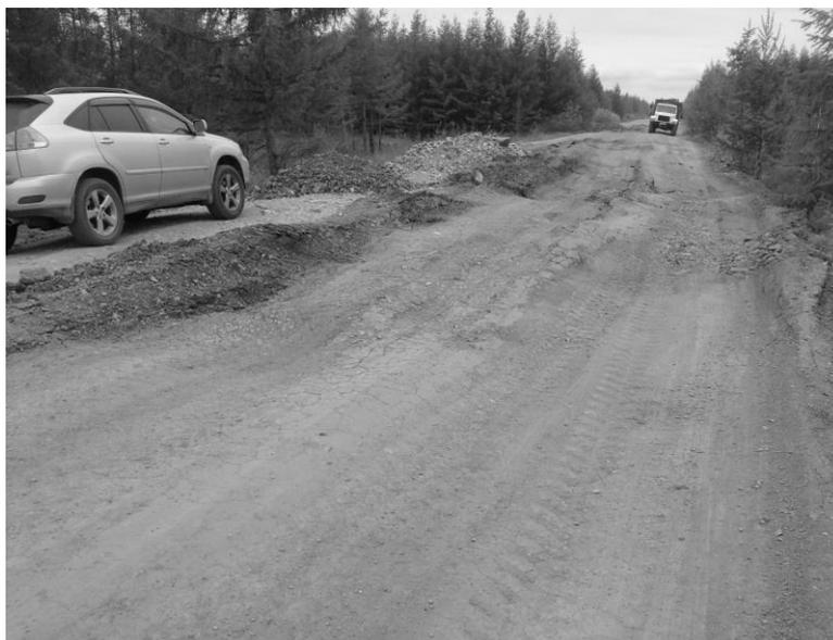
**Рис. 2. Просадки насыпи автомобильной дороги на участке Сохондо-Могзон**
