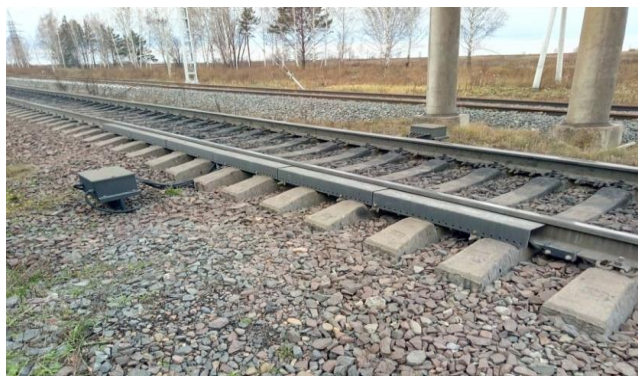
Рис. 5. Расположение напольного оборудования комплекса ПАУК-11к
