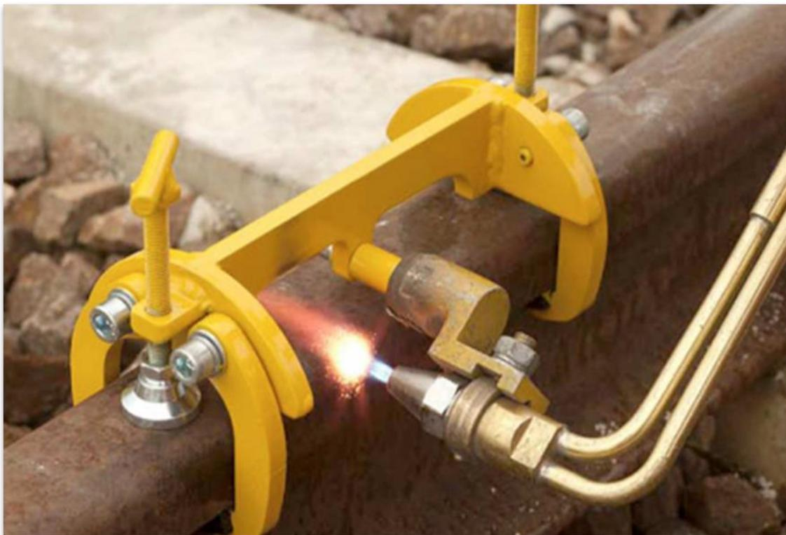
**Рис. 5. Процесс газовой резки головки рельса**
