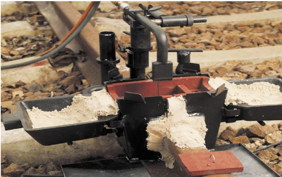
**Рис. 7. Установка горелки предварительного подогрева вместе с формами**
