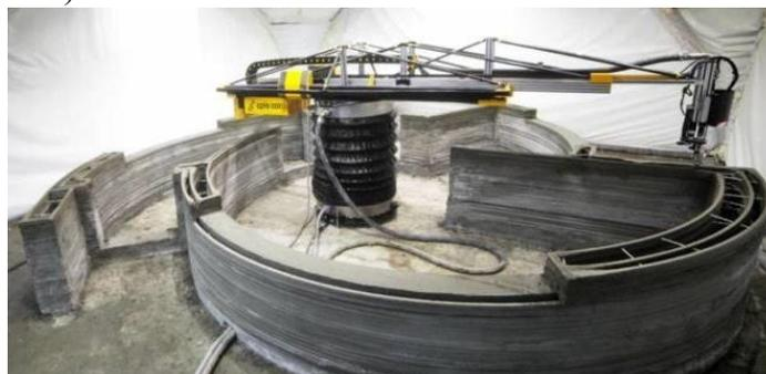
Рис. 2. 3D-принтер кранового типа
