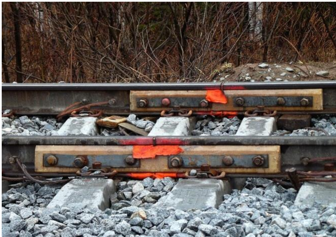
Рис. 4. Рельсовый стык с композитными накладками
