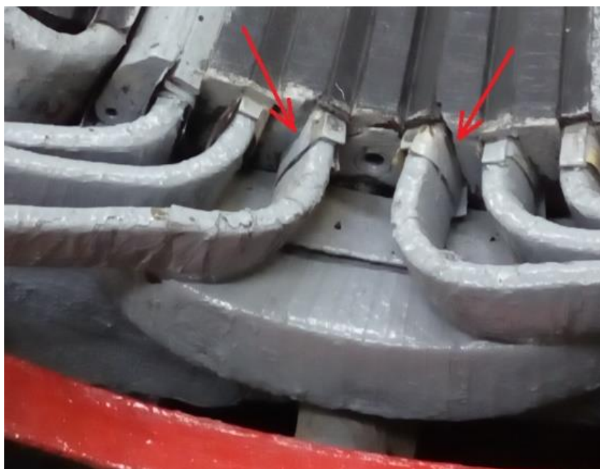
Рис. 1. Витки компенсационной обмотки в пазах главного полюса
