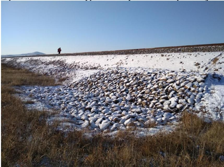
**Рис. 3. Фильтрующая насыпь на участке обследования**
