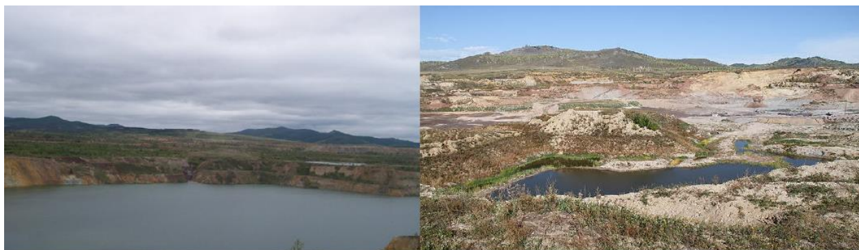
Рисунок 3. Геомеханическое нарушение окружающей среды в районе г. Бaley ( http://photogoroda.com ; http://www.wtz.com/baley )
